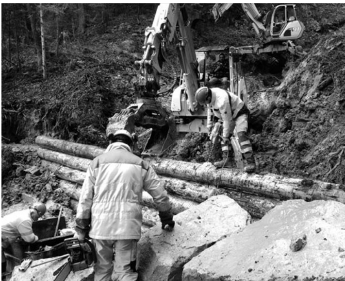
Von April bis November arbeiten Mitarbeiter der Gewässerunterhaltsgruppe an den neuen Wildbachsperren, die vor Hochwasser und Murgängen schützen.
