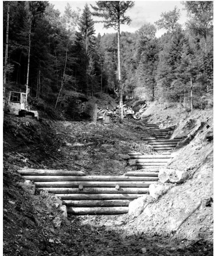
Rundholzsperrern wie diese in Waldenburg schützen vor Murgängen und Hochwasser.
