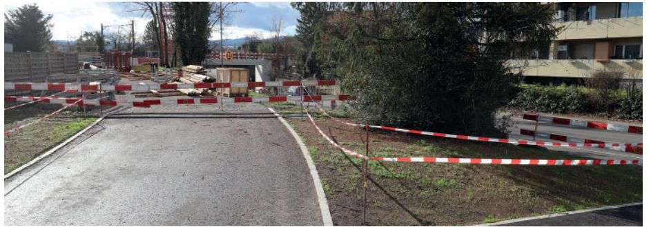
Der neue Fuss- und Veloweg in Blickrichtung der neuen Brücke.
