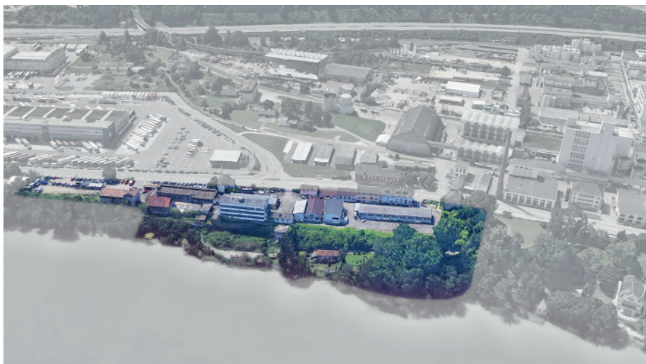
Der belastete, sanierungsbedürftige Standort Rheinlehne. Quelle: Google Earth
